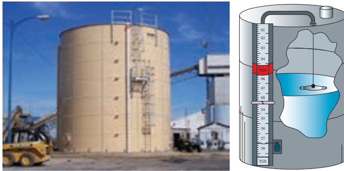
شکل ۳- اندازه‌گیری ارتفاع سطح سیال با استفاده از سطح‌سنج در تانک ذخیره
