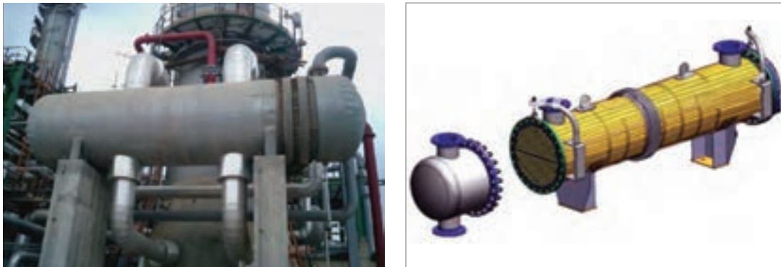
شکل ۲۹- مبدل حرارتی پوسته و لوله (نماهای بیرونی و داخلی)
