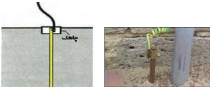
شکل ۴ - شیوه اتصال به چاه ارت
