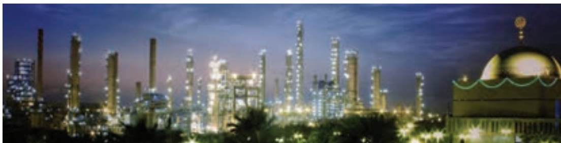
شکل ۲- یکی از مجتمع‌های پتروشیمی
