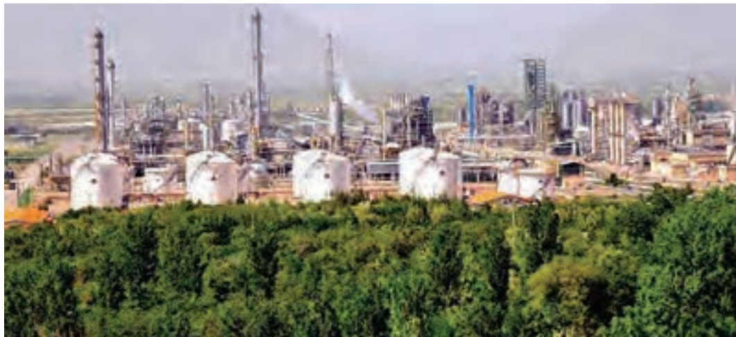
شکل ۳- یکی از مجتمع‌های پتروشیمی
